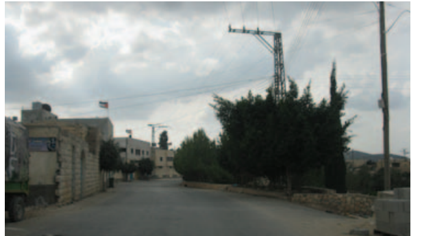
منطقة ذات ضغط مياه غير مناسب (منخفض)
