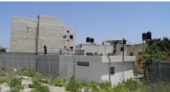
محطة تعزيز ضخ المياه في قباطية
