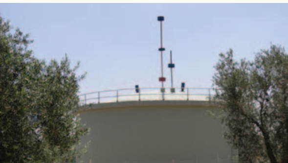
خزان مياه في قباطية
