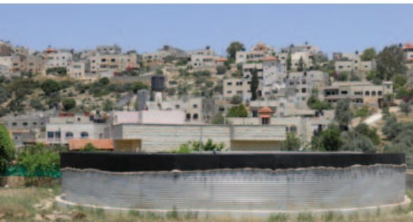
خزان مياه لاغراض الزراعة
